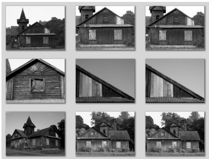
Rysunek 6.5. Na potrzeby utworzenia pojedynczej tekstury drewnianej ściany wykonano kilkadziesiąt zdjęć przedstawiających różne ujęcia i fragmenty budynku
