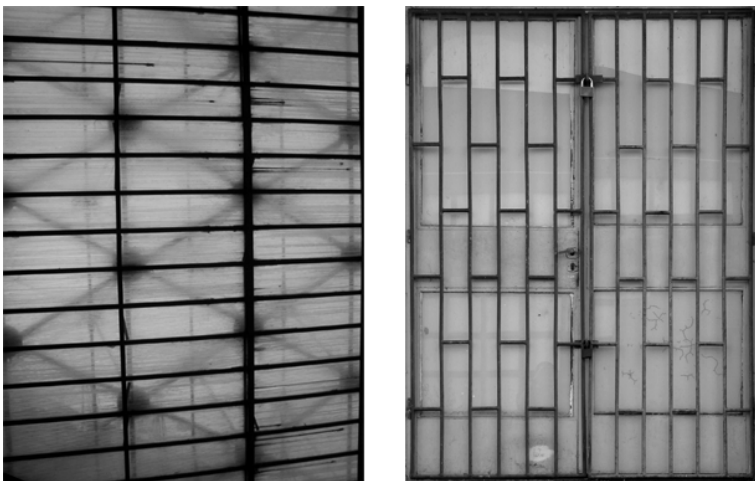
Rysunek 6.3. Po lewej - przykład zdjęcia zniekształconego (perspektywa i deformacje beczkowate). Po prawej - zdjęcie jest wykonane prawidłowo (brak perspektywy i łuków)
